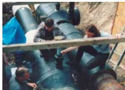
Ballostar předběžně izolovaný: před, během a po vestavbě
